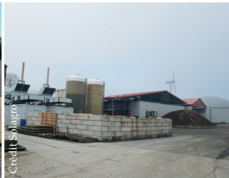
Voie sèche continue
