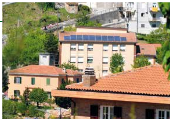
Toiture photovoltaïque sur un établissement public (Italie)
