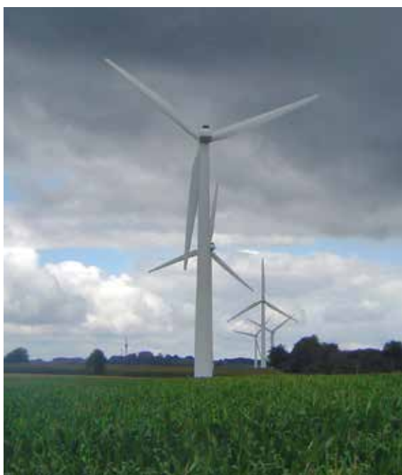
Parc éolien, communauté de communes du Mené (France)
