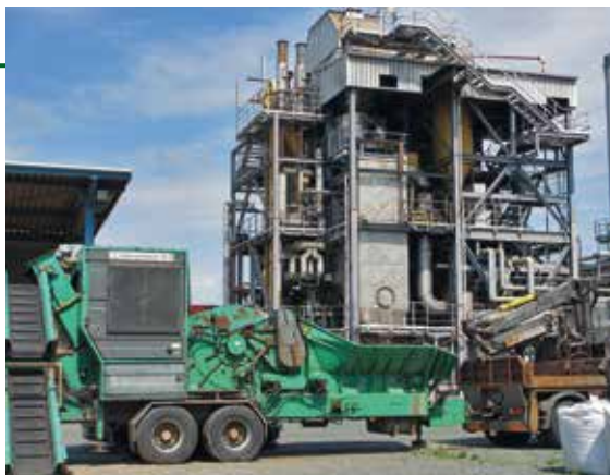
Usine de gazéification de la biomasse, Güssing (Autriche)
