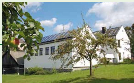
Isolation thermique, Ecole Albrechtsberg (Autriche)
