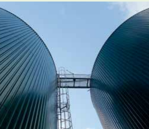
Digesteurs à biogaz.
